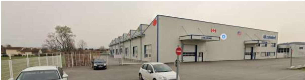
Vue sur la limite Nord de l’usine, habitat pavillonnaire en arrière-plan
