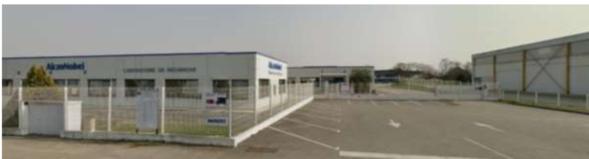
Vue sur la limite Ouest de l’usine, gymnase à droite
