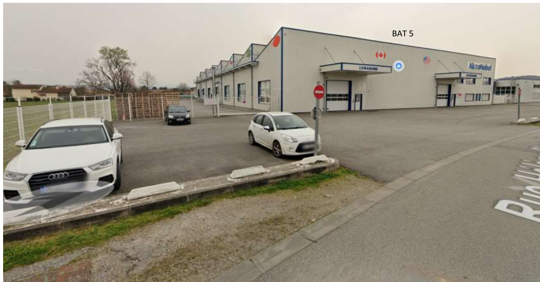
Figure 13: Photo 3 (Google Street View - Mars 2021) : Nord-Est du site et Bâtiment 5
