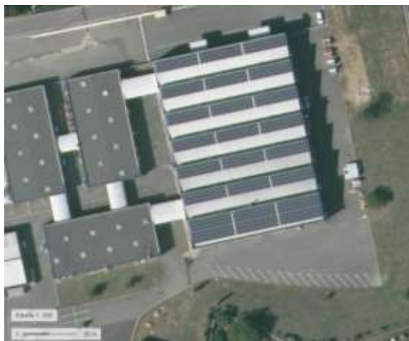
Figure 17: Toiture photovoltaïque bâtiment 5
