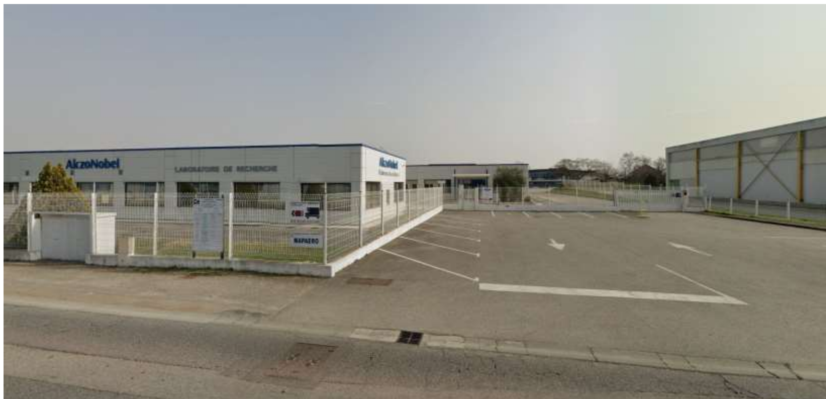
Figure 14: Photo 4 (Google Street View - Mars 2021) : Ouest du site – Bâtiment administratif et Laboratoire de recherche
