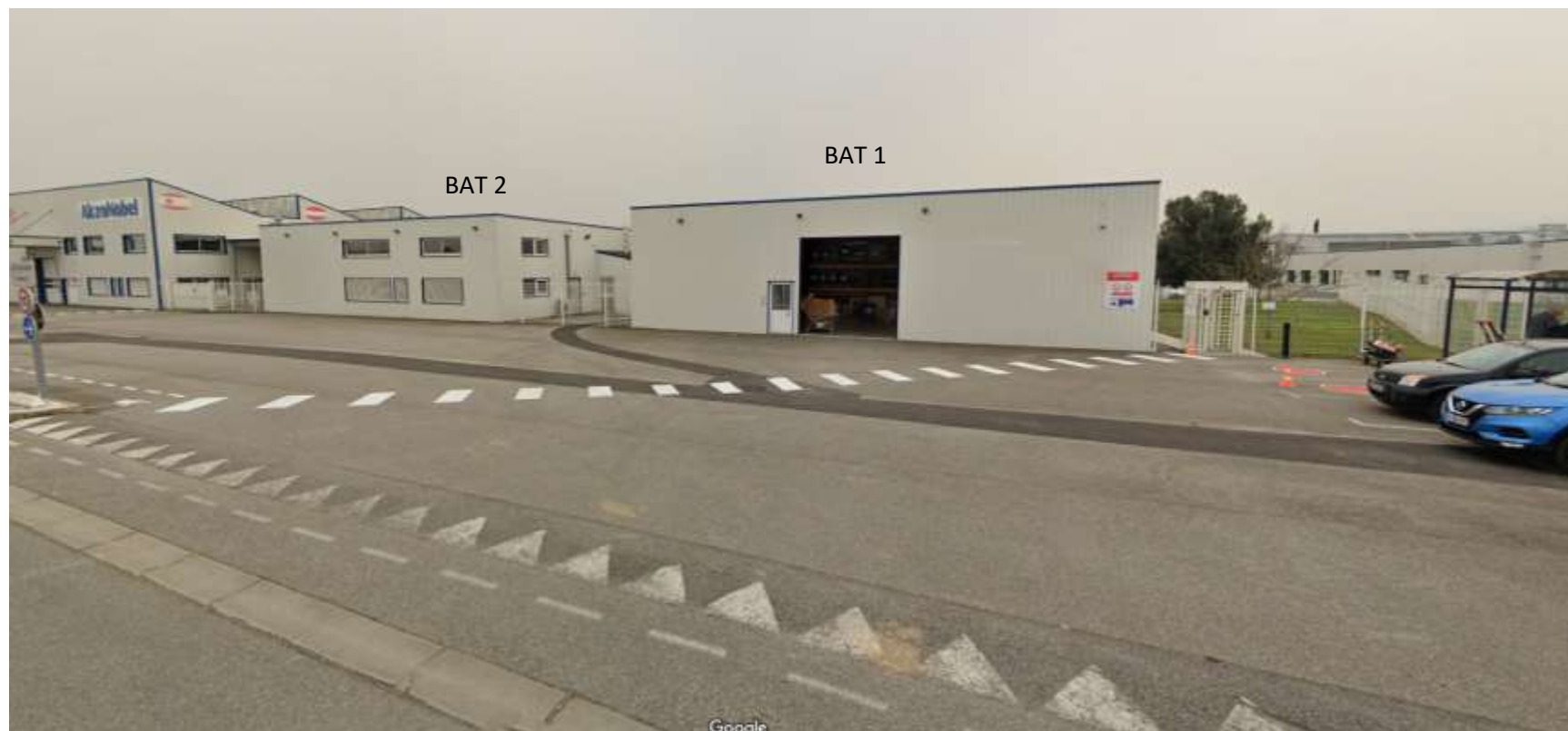
Figure 12: Photo 2 (Google Street View - Mars 2021) : Nord-Ouest du site
