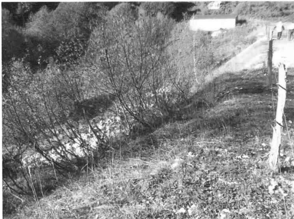
Figure 10 : Vue aval du barrage.
