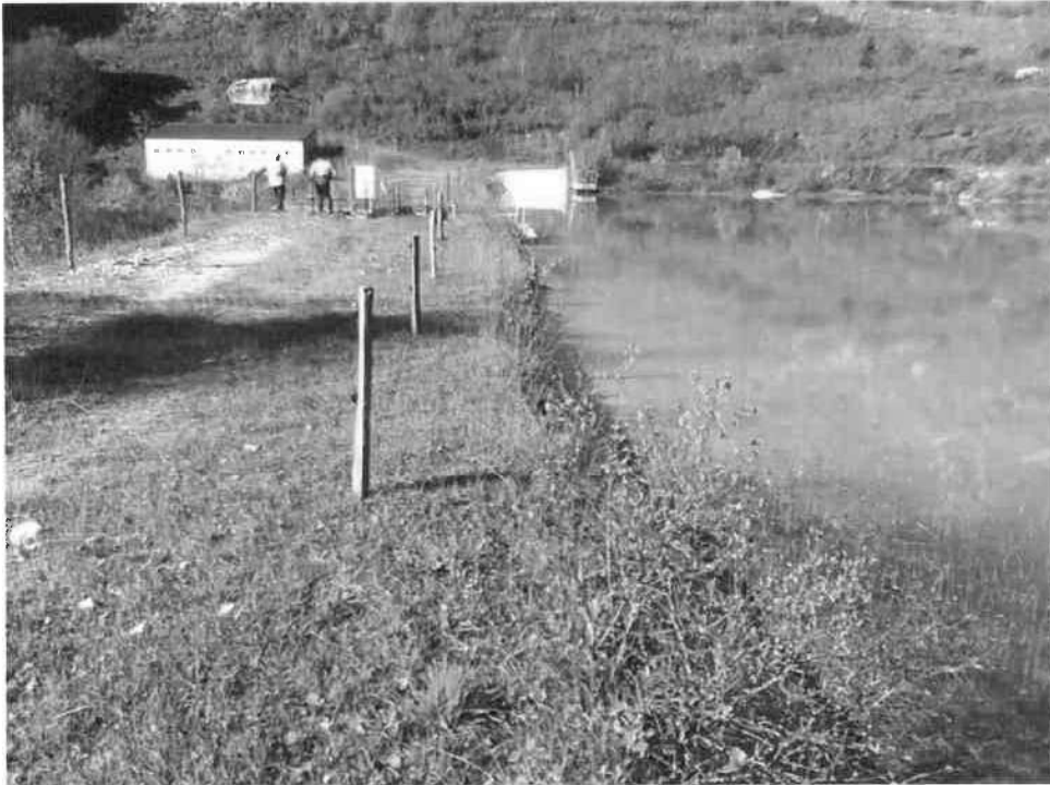
Figure 9 : Vue amont du barrage.
