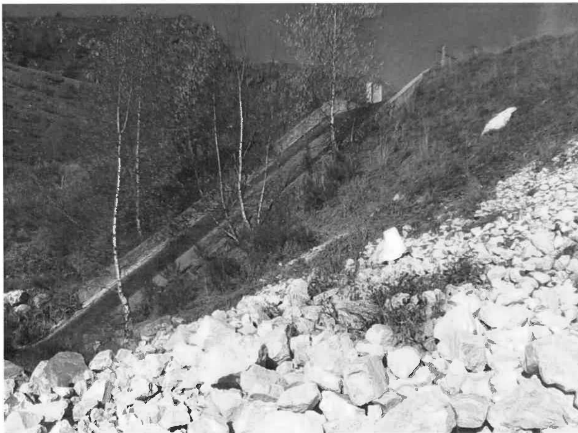
Figure 11 : Evacuateur de crues
