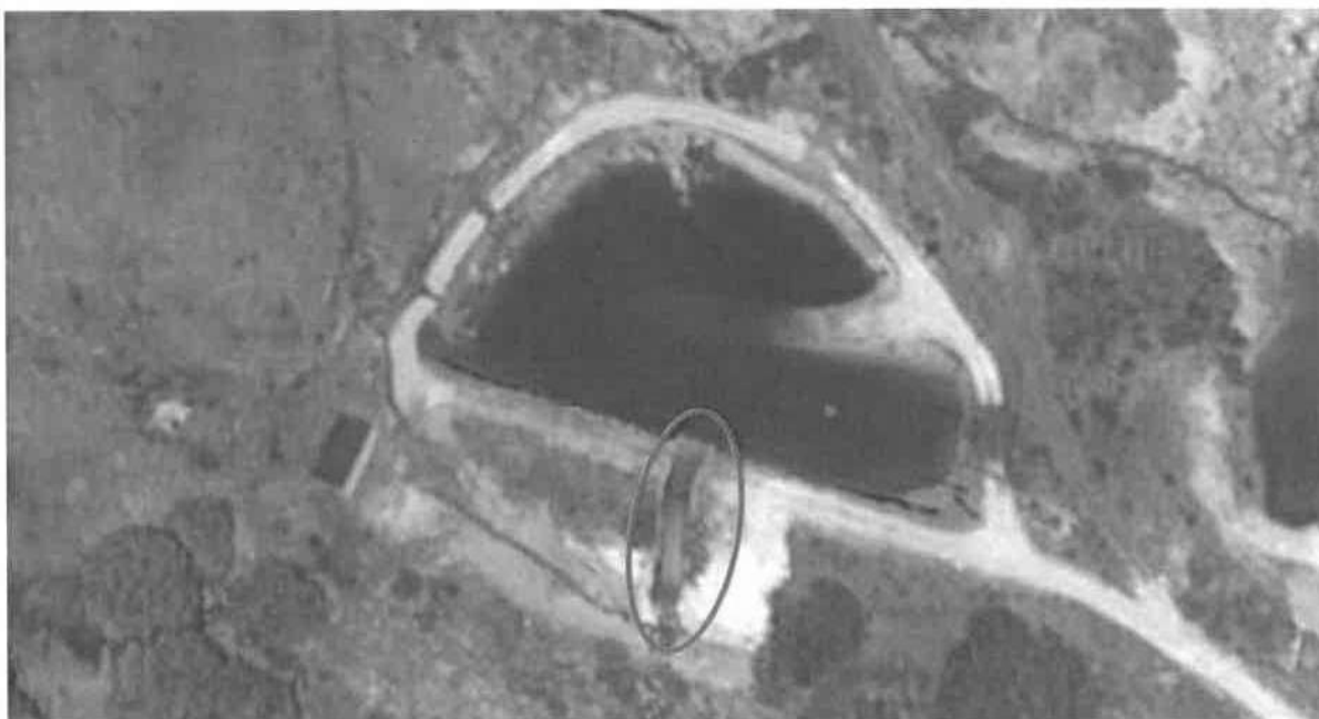
Figure 12 : Localisation du déversoir et de son coursier (Google Maps)
