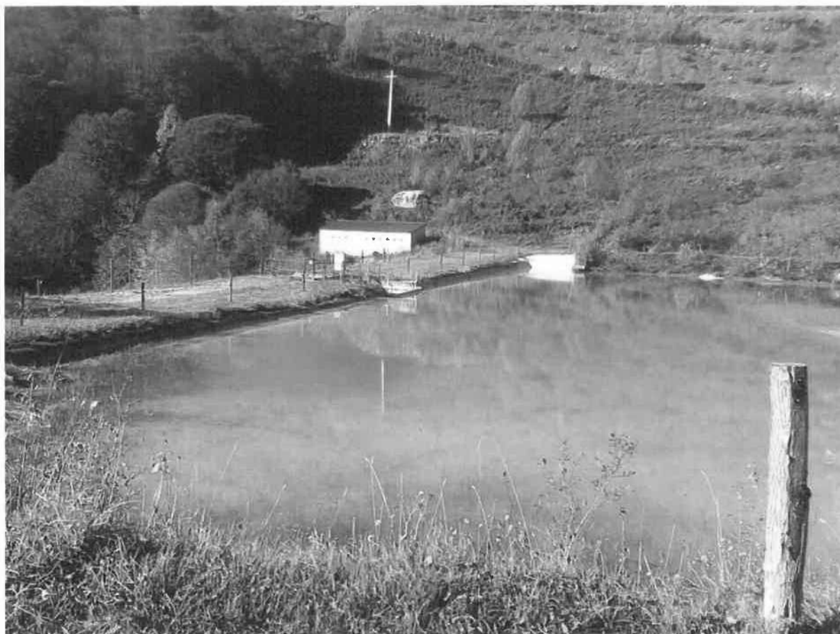
Figure 5 : Retenue des Fourmis, (Cliché AGERIN, 2014)
