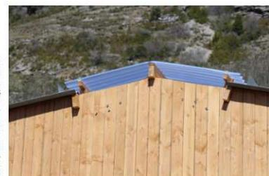
Détail du faitage offrant un puits de lumière et permettant la ventilation de la stabulation, pour le bien-être des hommes au travail et des animaux.
