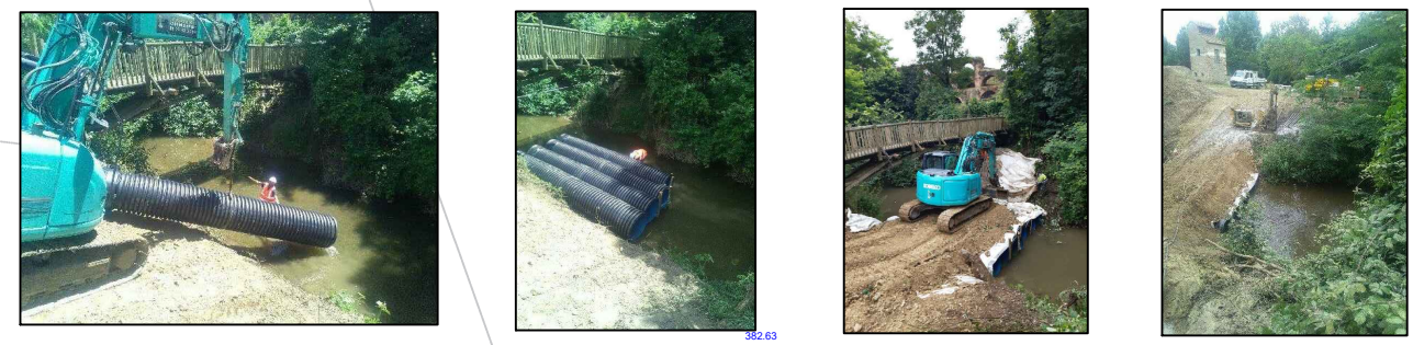
Exemple de réalisation d'un pont canadien provisoire sur buse Ecopal Ø800 + géotextile
